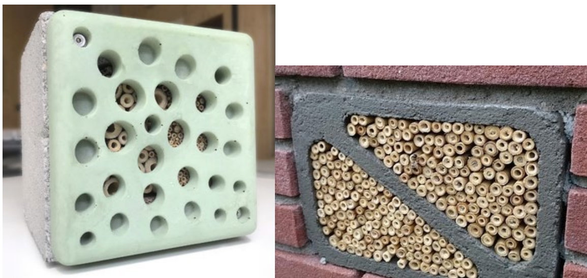
Figuur 2. Bijenstenen gevuld met bamboe- of rietstengels. De steen op de linkerfoto bevat wel geschikte stengels van verschillende doorsnedes, maar door het afdekplaatje zijn veel stengels niet (goed) toegankelijk.
