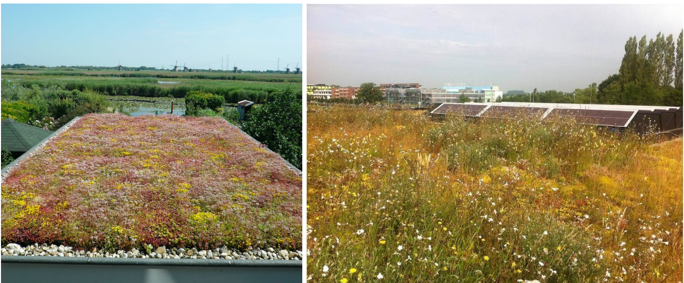
Figuur 4. Sedum -dak (links) en kruidenrijk groen dak (rechts).
