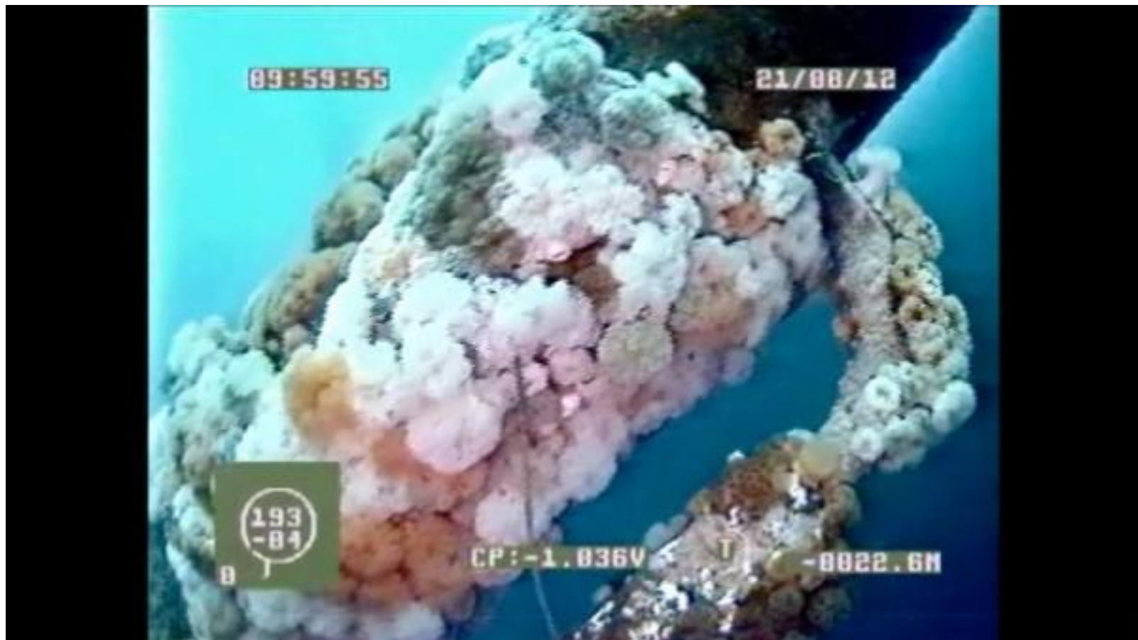
De fundering van een gasplatform in de Noordzee
